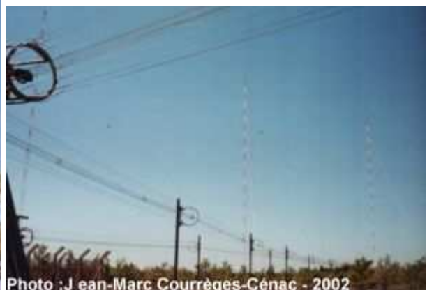
les antennes G.O. avec en premier plan les feeders
